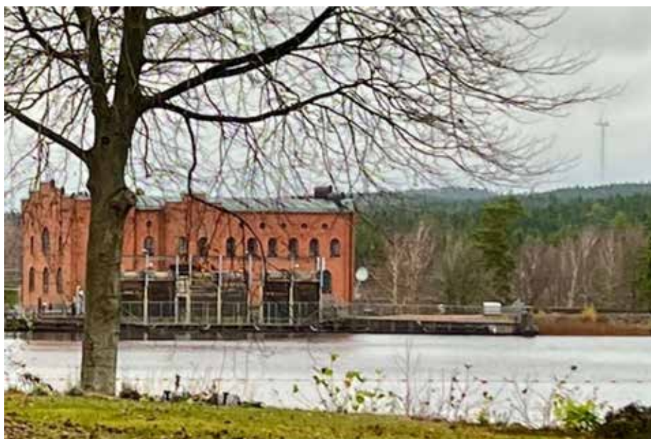
Kraftverket vid Knäred Övre med dammen som Statkraft vill fylla igen.
