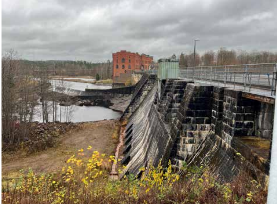
Kraftverket vid Knäred Övre med dammvallen och den gamla åfåran i förgrunden.
