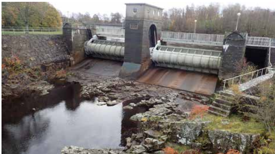
Dammvall och damluckor vid Laholms kraftverk.
