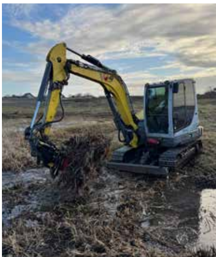
Grävmaskin under arbetets gång.
