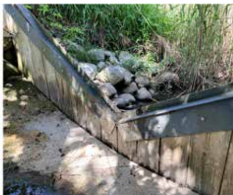
Utloppen i två olika våtmarker. Den ena våtmarken hade genomflöde av vatten under sommarhalvåret (vänster) medan den andra saknade sommarflöde (höger). Hur kväveavskiljningen påverkades av detta undersöktes i en fältstudie.
