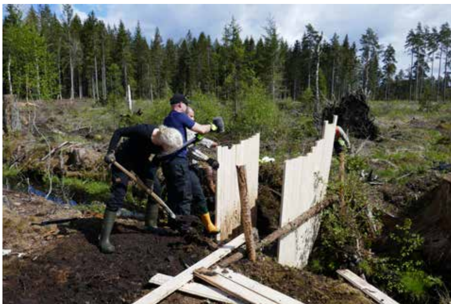
Att bygga en palissadplugg är bästa metoden för att plugga ett dike. Foto: Stefan Anderson.
