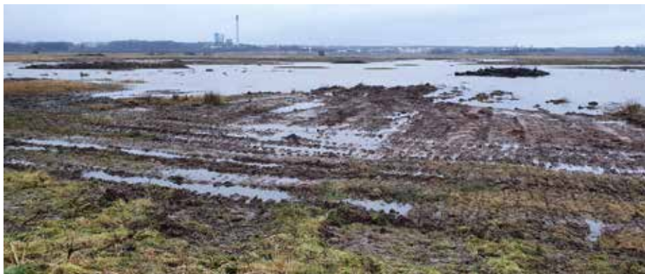
Trönninge ängar 2022, gamla dammen: en ny ö, fyra nya grundområden, sänkt markyta på gamla öar, ny backsvalekoloni, avfasade slänter, sex faunadepåer (2–5 skotarlass helträds-lövved per depå) och uppgrundade (ca 30 cm) djupdelar på 1–2 hektar. Foto: Hans Bjuringer.
