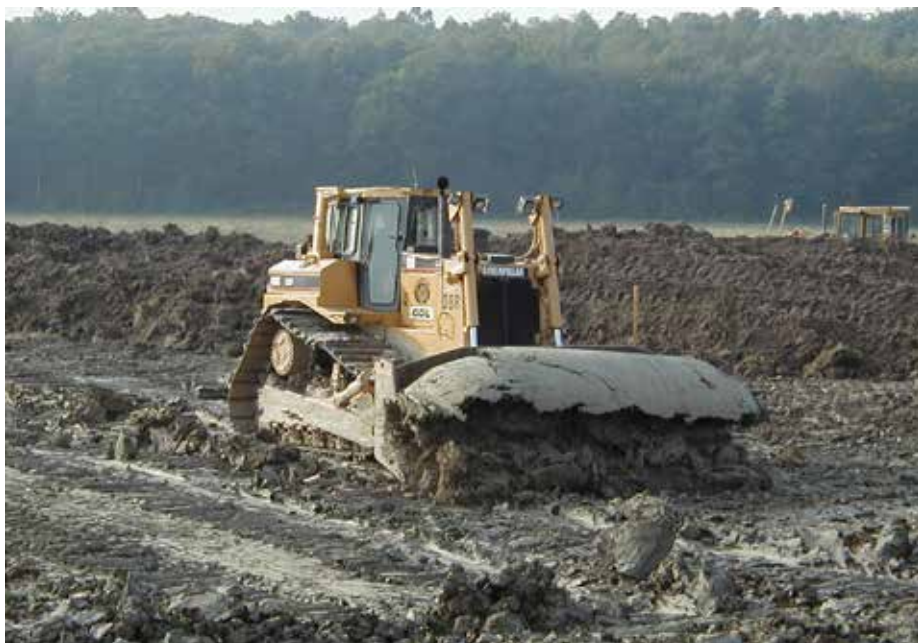
Schaktningsarbeten i samband med anläggandet av Särdals våtmark. Foto: Hans Bjuringer.
