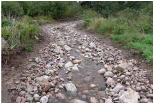
Figur 3. Till vänster: en tidigare kulverterad sträcka har öppnats till ett levande vattendrag i Stjärnarp i projektet LIFE-Goodstream. Till höger: vi har lagt i sten i delar av den nya sträckan som leder in till en nyrestaurerad liten våtmark. Tanken är att det ska gynna fiskvandring och även andra djurarter i Trönningeån. Foto: John Strand.
