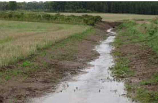
Figur 3. Till vänster: en tidigare kulverterad sträcka har öppnats till ett levande vattendrag i Stjärnarp i projektet LIFE-Goodstream. Till höger: vi har lagt i sten i delar av den nya sträckan som leder in till en nyrestaurerad liten våtmark. Tanken är att det ska gynna fiskvandring och även andra djurarter i Trönningeån. Foto: John Strand.
