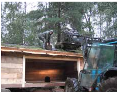
Bo Hansson lägger grästorvorna som utgör yttertak på plats.
