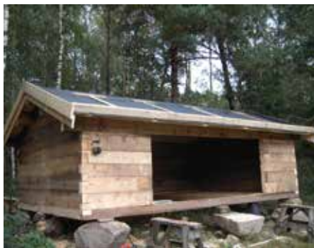
Tak och vindskenor är på plats och taket är klätt med platonmatta för att skydda från fukt.
