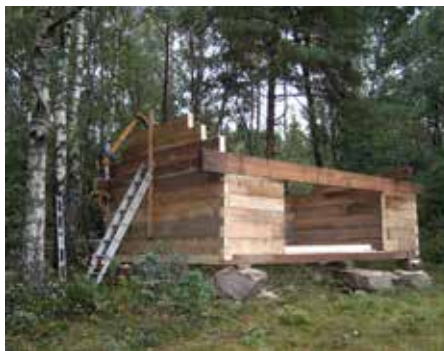
Här är vindskyddets väggar till största delen uppförda.
