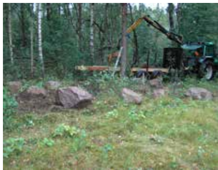
De stenbumlingar som utgör vindskyddets grund har lagts på plats med hjälp av traktorgrip.
