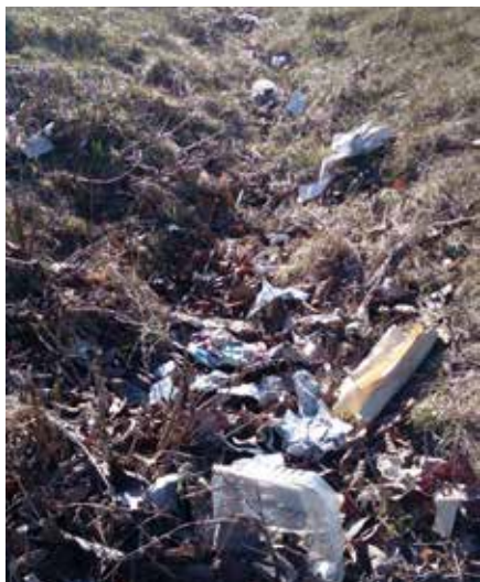
Vägdike fyllt av plastskräp.
