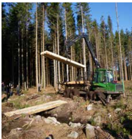
Figur 7. Utläggning av stockmattor över mindre vattendrag. Foto: Anders Hejnebo.
