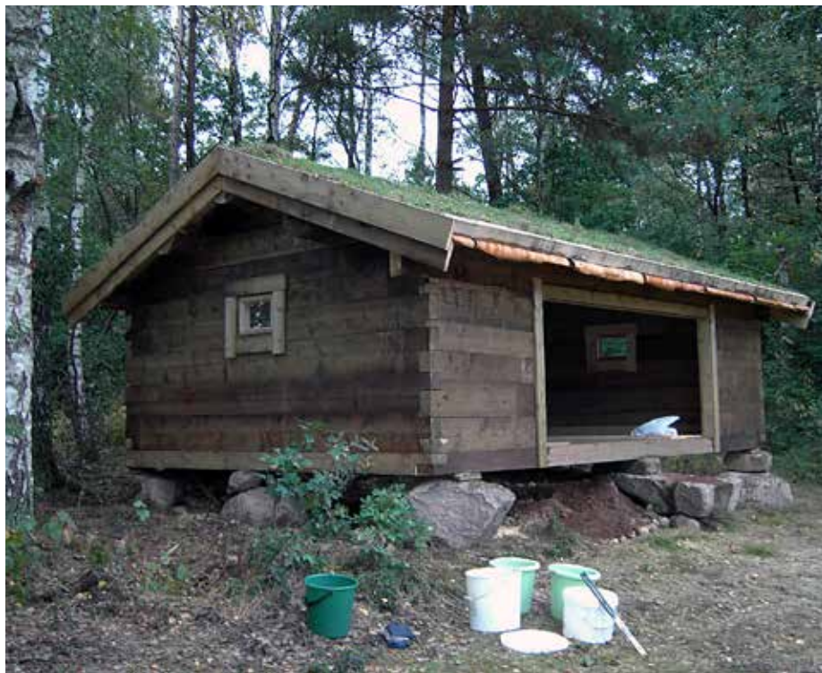
Vindskyddet efter det att Bo Hansson och Nils-Olof Petersson målat det med järnsulfat.
