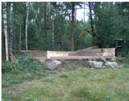
Grunden är anlagd och vindskyddets väggar har börjat sättas upp.
