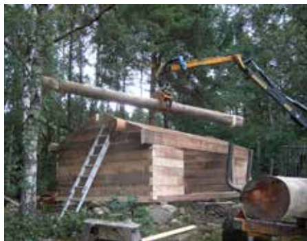
Det spännande momentet när de cirka 500 kilo tunga takbjälkarna lyfts på plats.
