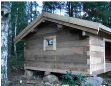
Fönstergluggar är utsågade och fönster är satta på plats.
