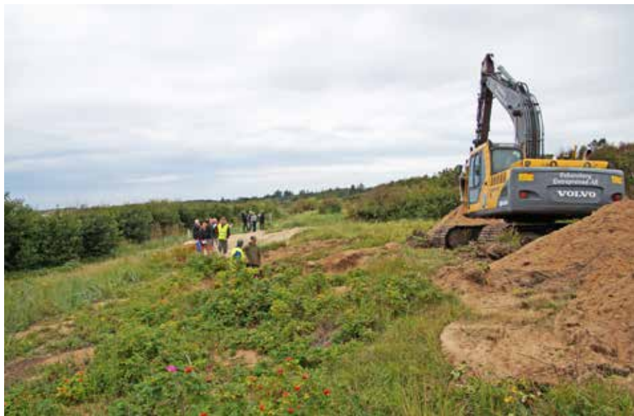
För att bli kvitt vresrosorna på reservatet används en stor grävmaskin.
